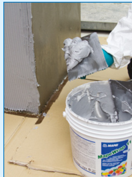
Rasatura con MapeWrap 11 o MapeWrap 12
