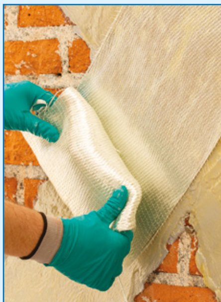
Applicazione del tessuto MapeWrap G UNI-AX
