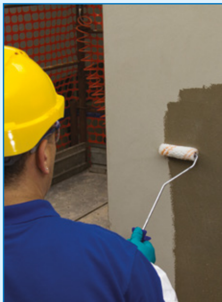
Applicazione di MapeWrap Primer 1
