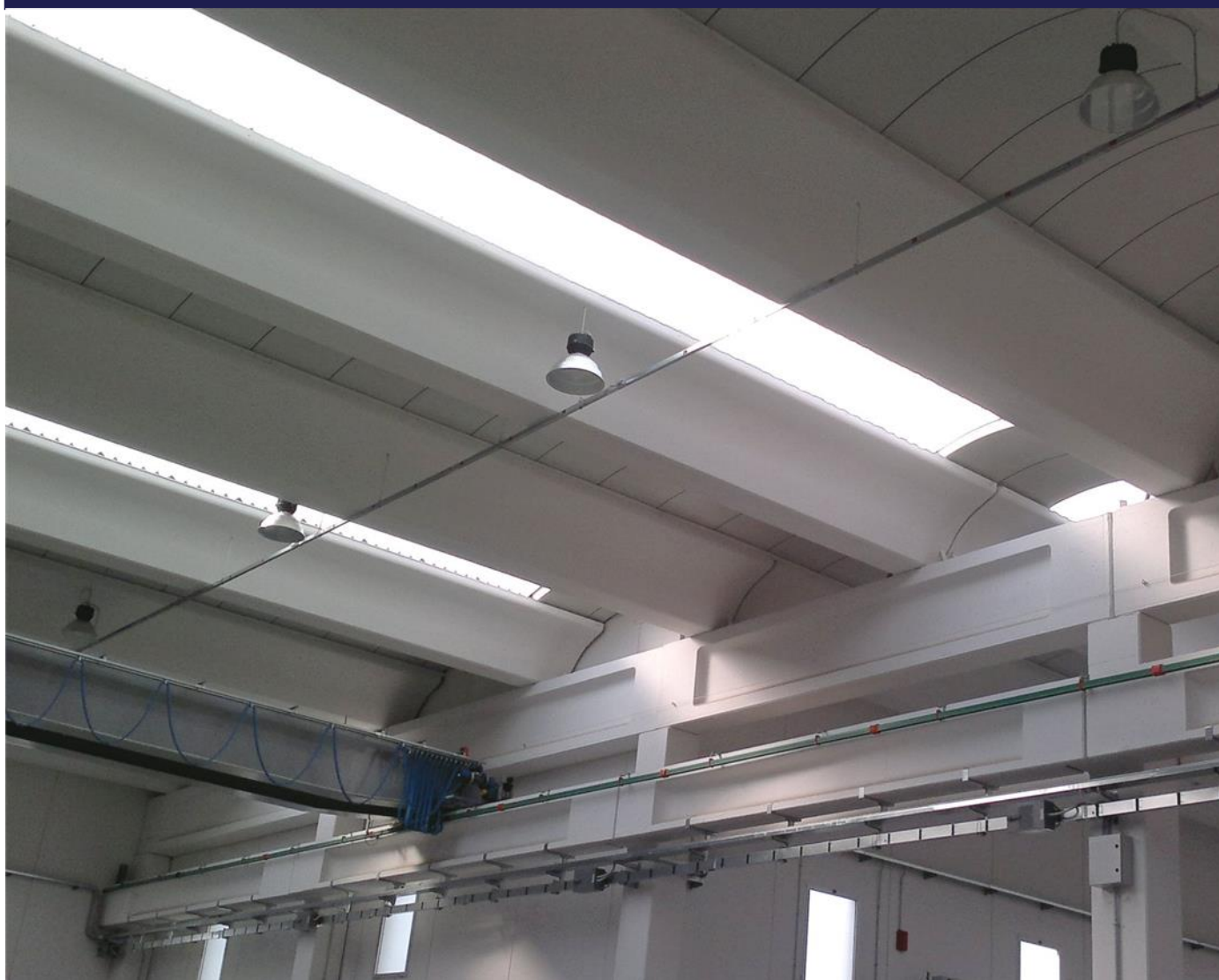
TRAVI I 80 - Utilizzo come appoggio per tegoli ALA e come via di corsa per carro ponte
