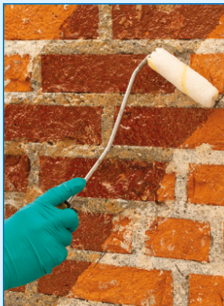
Applicazione di MapeWrap Primer 1
