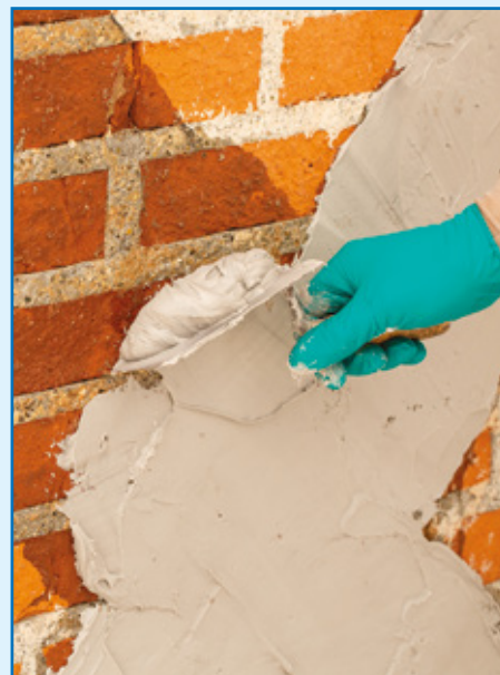
Rasatura con MapeWrap 11 o MapeWrap 12
