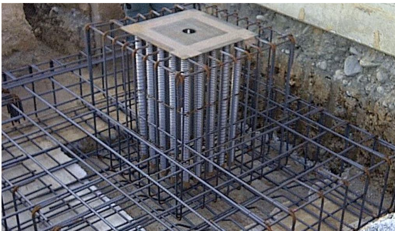
Piastra armatubo posizionata sulla gabbia di armatura
