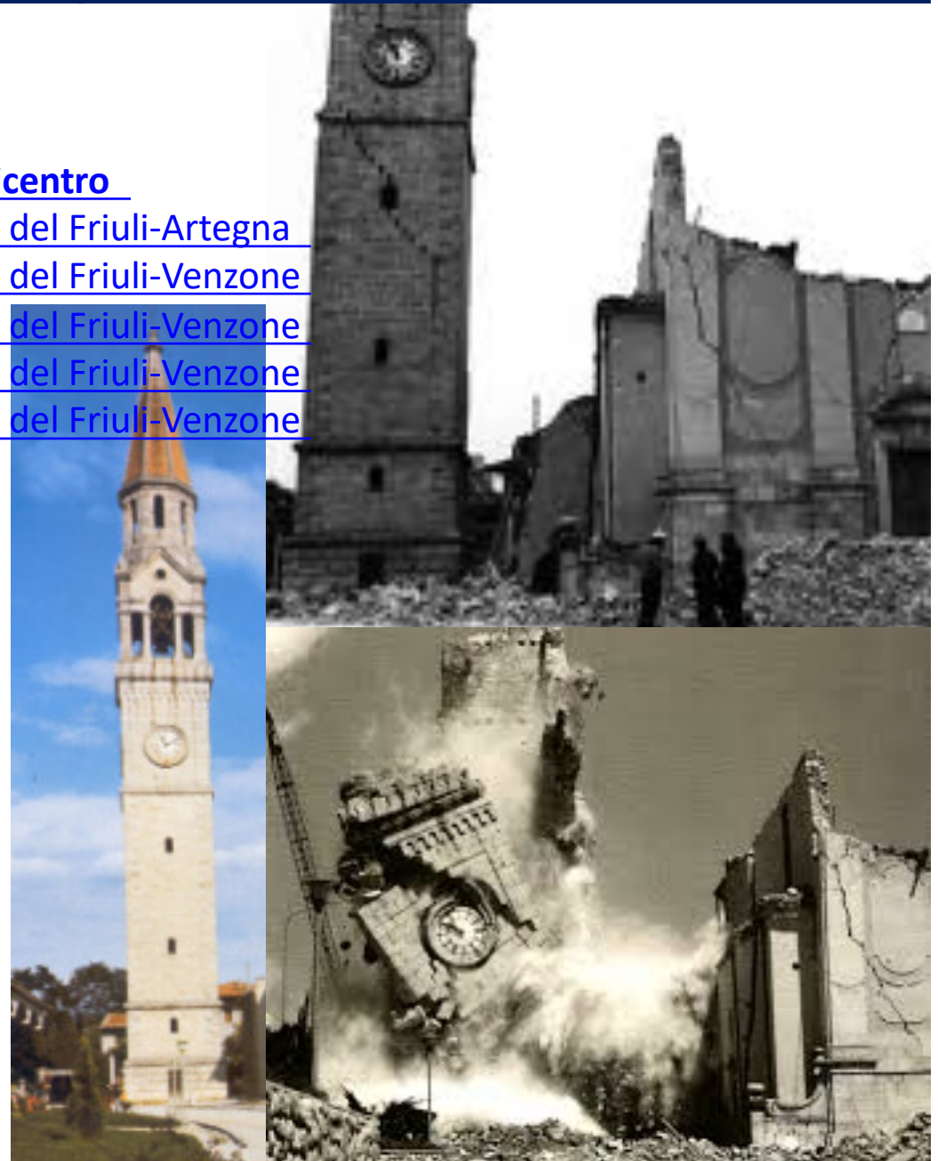
Crollo e successiva demolizione del campanile di Moiano
